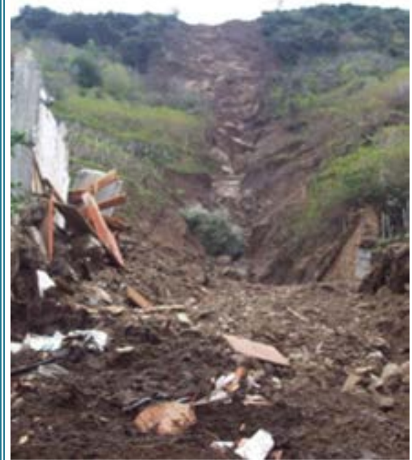
Parte bassa e terminale del fenomeno franoso, che ha coinvolto la SS18 tra Scilla e Bagnara, la ferrovia e l'abitato di Favazzina.
